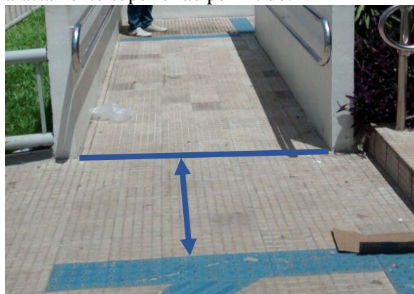
Figura 7. Vista de uma das rampas com afastamento superior ao permitido.
